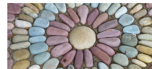
Cerrig mân wedi'u gosod mewn mortar
